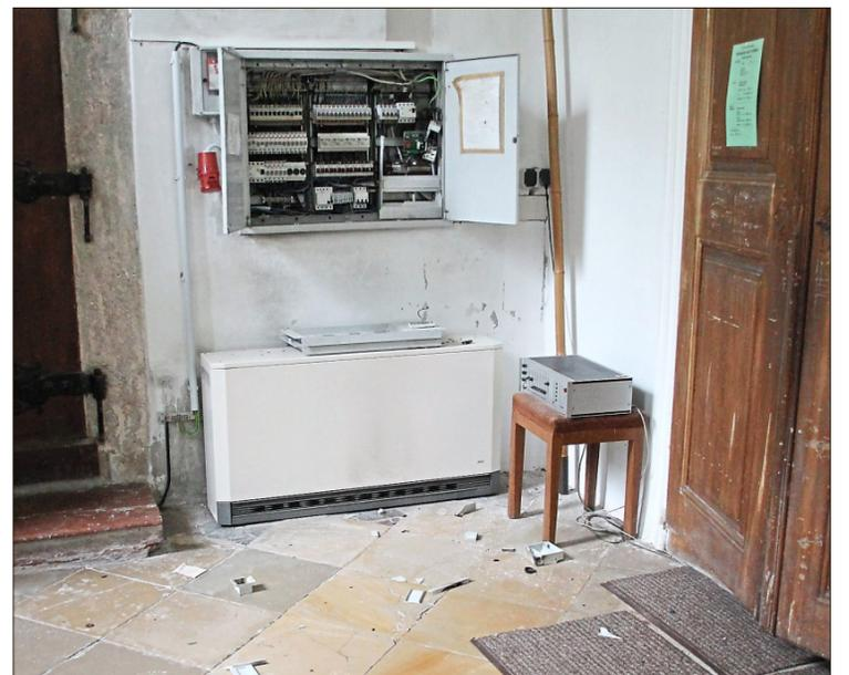
Die hohe Spannung des Blitzeinschlages schleuderte Teile des Sicherungskastens quer durch die ganze Sakristei.
