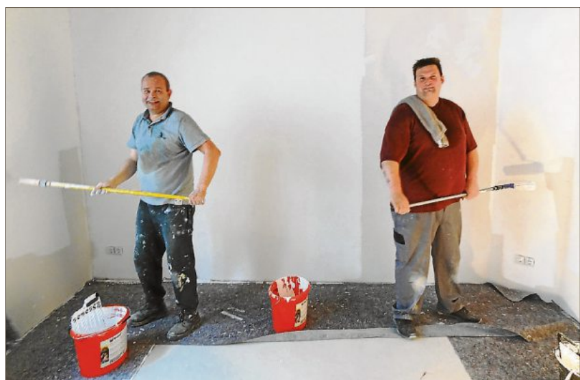
Pfarrer Hasso von Winning sucht noch Bauhelfer, die im neuen Familienhaus an der Eichendorffstraße beim Streichen und Fliesen legen helfen.
